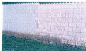
On voit bien la différence entre parpaings gris et parpaings beige
